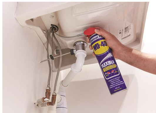
Dégripper une vis ou un écrou sous évier.
