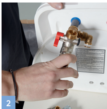
2 Monter les raccords hydrauliques
