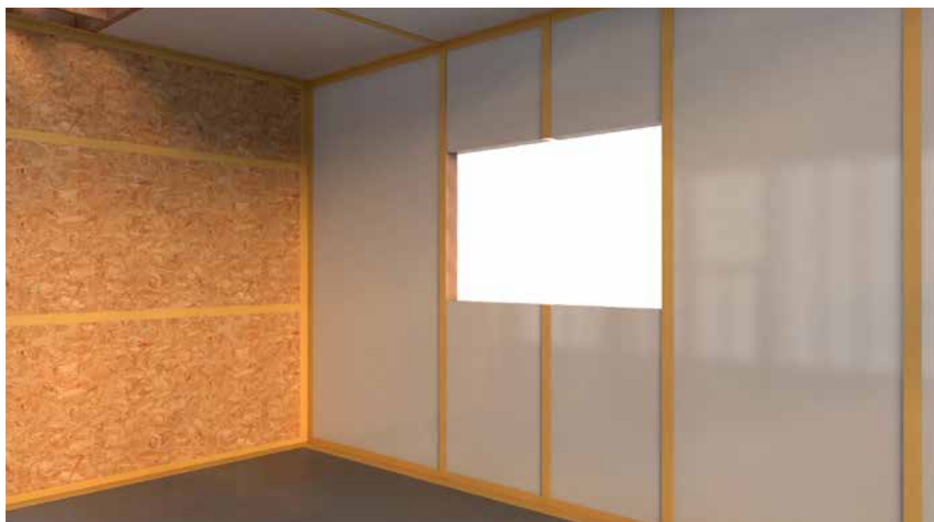
Jonctions de pare-vapeur et de panneaux OSB
