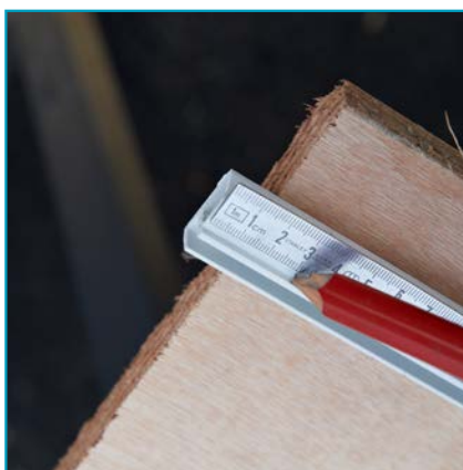
Commencer à tracer à 30 mm du bord de la baguette
