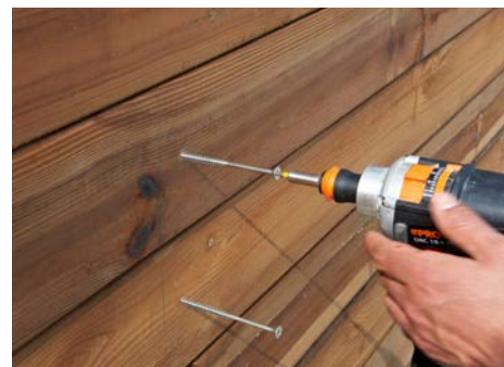
Positionner et visser depuis l'intérieur de la piscine
