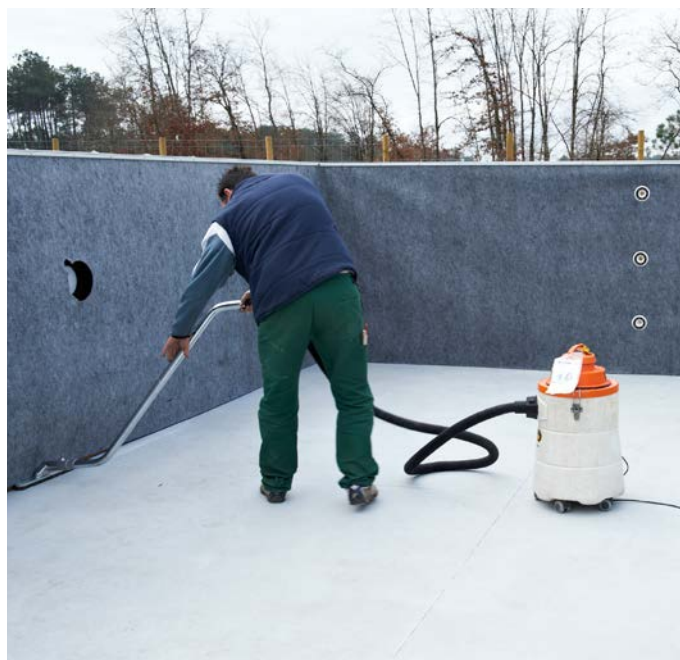
Nettoyer l'intérieur de la piscine
