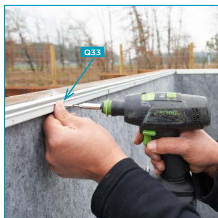
Visser les baguettes au niveau du bord supérieur du bastaing avec de la vis Q33
