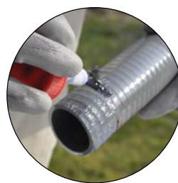
Coller l'extérieur du tube
