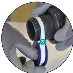
Enrouler le ruban autour du filetage 3 Enrouler dans le sens des aiguilles d'une montre jusqu'au maintien du filetage. Le raccord à rendre étanche doit être propre et en bon état.
