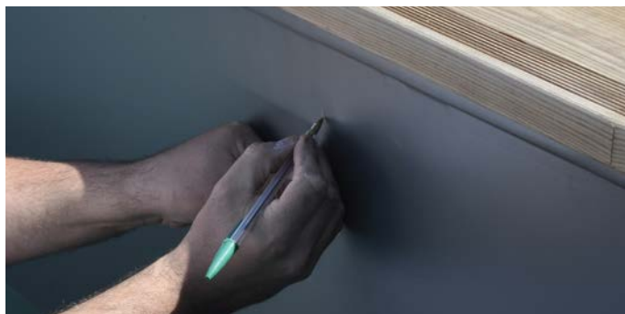
Repérer à l'aide d'un stylo la position des trous des vis
