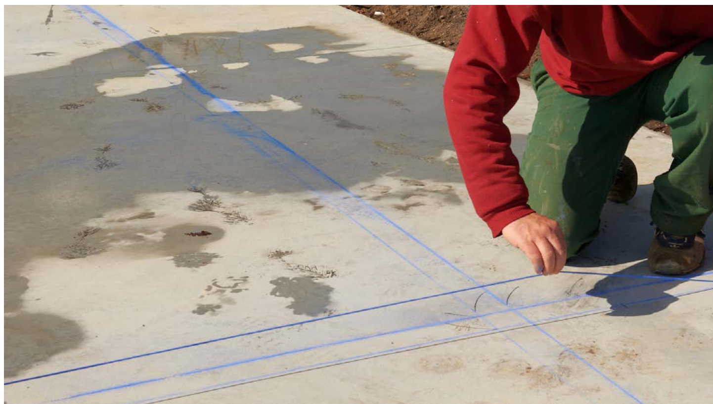
Traçage d'un angle
