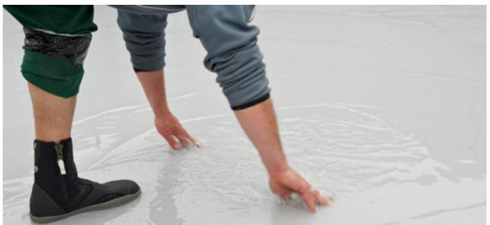
**F -** La fixation des pièces (buse de refoulement, projecteur, prise balai et skimmer) se fait lorsque l'eau arrive à 50 mm des pièces. Pour la bonde de fond, il faut attendre d'avoir au moins 100 mm d'eau
