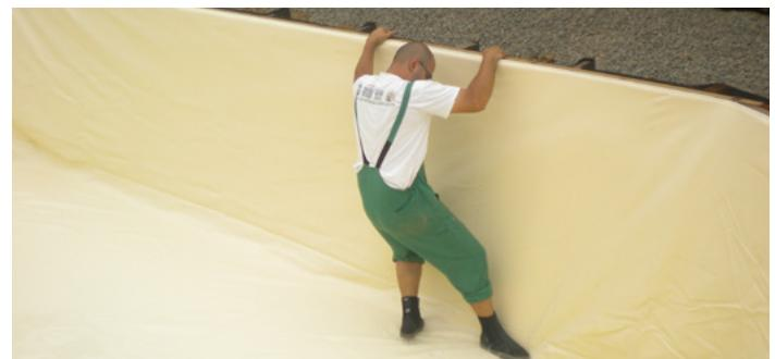
**E -** Remplir et commencer à lisser les plis : partir du centre de la piscine vers les extérieurs. Pour pouvoir lisser correctement, le niveau d'eau dans la piscine ne doit pas dépasser 30 mm.
