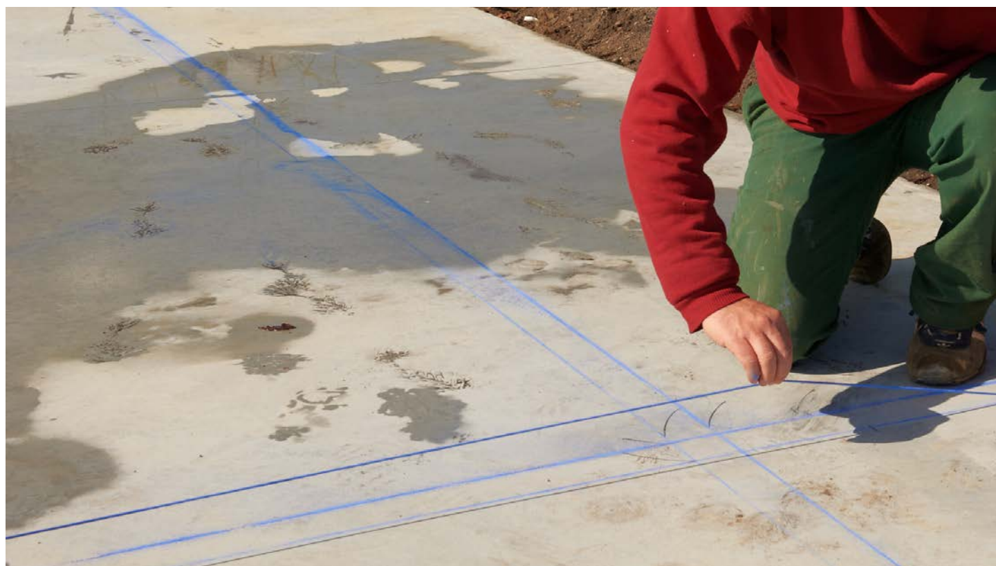
Traçage d'un angle
