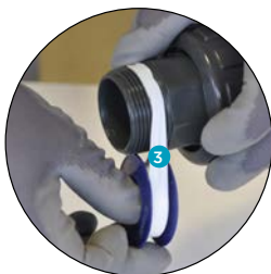
Enrouler le ruban autour du filetage ③ Enrouler dans le sens des aiguilles d'une montre jusqu'au maintient du filetage. Le raccord à rendre étanche doit être propre et en bon état.
