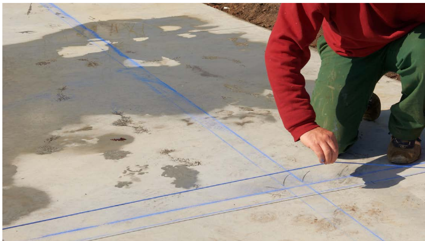
Traçage d'un angle
