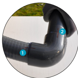
Maintenir le collage 1 Tuyaux souple : temps de fixation 1 min 2 Tuyaux rigide : temps de fixation immédiat
