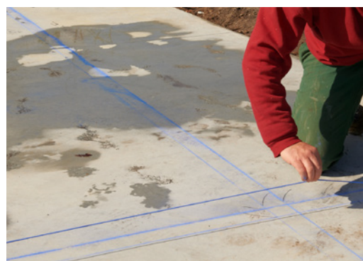
Traçage d'un angle
