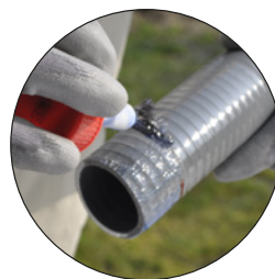
Coller l'extérieur du tube
