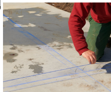
Traçage d'un angle
