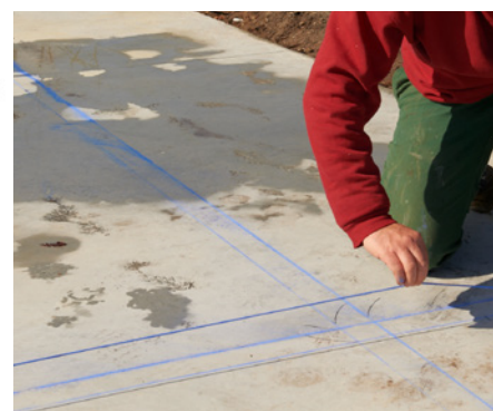
Traçage d'un angle
