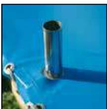
Les bâches sont prédécoupées pour permettre l'insertion des supports de l'échelle inox.
