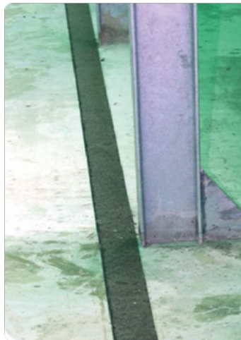
Figure 8 – Mise en place des bandes bitumeuses
