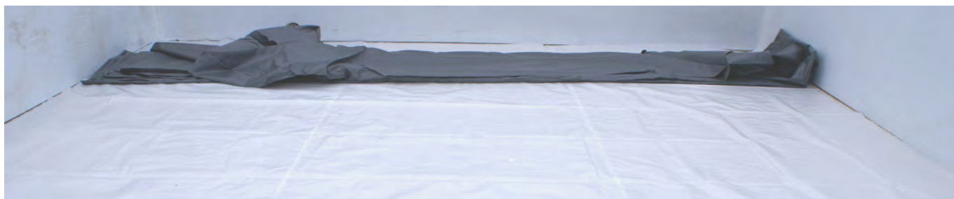
Figure 33 – Dépliage du liner
