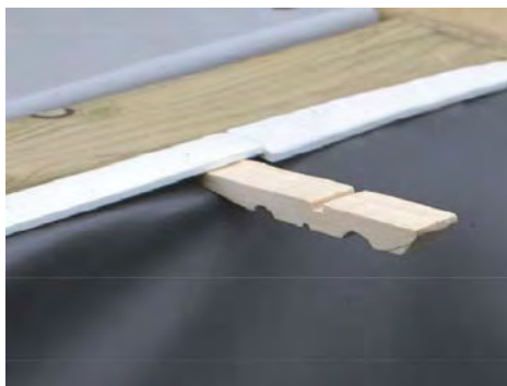
Figure 32 – Verrouillage du liner grâce à des demi- épingles à linge
