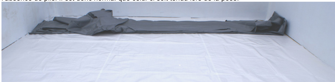
Figure 34 – Dépliage du liner
