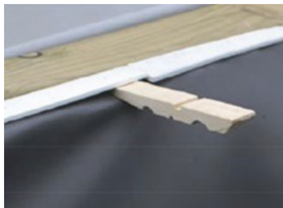
Figure 33 – Verrouillage du liner grâce à des demi épingles à linge
