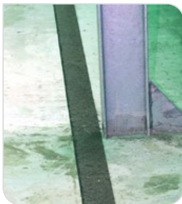
Figure 15 – Déroulage des bandes bitumeuses
