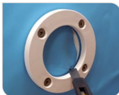
Figure 52 – Découpage du liner
