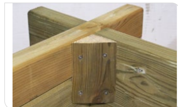
Figure 26 – Pièce de bois dans un angle
