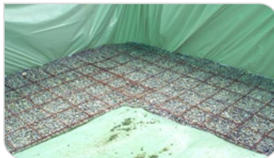
Figure 3 – Fond de la fouille
