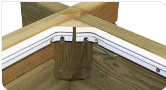
Figure 28 – Rail posé affleure de la structure
