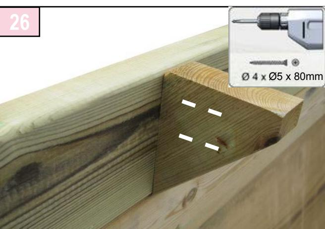
Les consoles sont destinées à soutenir la margelle qui sera mise en place après le remplissage du bassin. Fixez, après avoir pré-percé les parois par l'intérieur de la piscine, chaque console (type L) à l'aide de 2 vis (sachet R) en prenant soin de les positionner à de niveau avec la partie supérieure de la structure. Après le vissage prenez soin d'éliminer toute écharde éventuelle.
