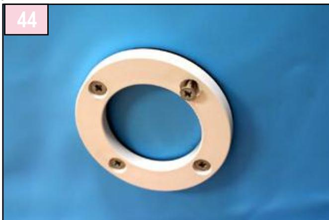
Effectuez le vissage de la bride équipée de son joint adhésif à l'aide des vis inox FZ M5x16 du skin pièce à sceller. Veillez lors de cette opération à effectuer un serrage alterné afin de garantir une parfaite étanchéité. Privilégiez un serrage manuel afin d'éviter un serrage trop brutal risquant de fendre la bride.
