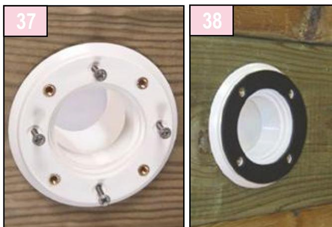
Placez, côté bassin, le corps de buse (Pack pièces à sceller) du refoulement dans l'orifice de la paroi percée.
