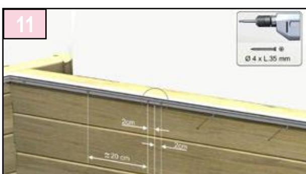
Fixez le rail à l'aide d'une vis à 2 cm de chaque extrémité. Puis complétez la fixation par environ une vis tous les 20 cm. Utiliser les vis Ø4 x 35 (sachet D).
