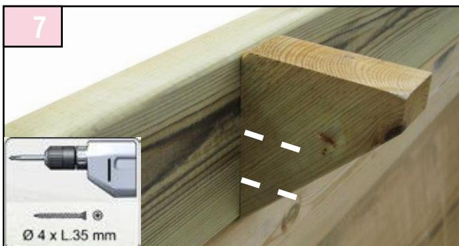
Les consoles sont destinées à soutenir la margelle qui sera mise en place après le remplissage du bassin. Fixez, après avoir pré-percé les parois par l'intérieur de la piscine, chaque console (type L) à l'aide de 2 vis (sachet J) en prenant soin de les positionner à niveau avec la partie supérieure de la structure. Après le vissage prenez soin d'éliminer toute écharde éventuelle.
