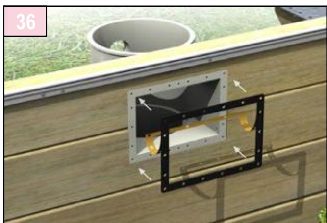
Avant de procéder à la pose du liner, collez un des 2 joints (skin pièces à sceller) adhésifs rectangulaires autour de la fenêtre du skimmer ou du bloc filtrant.
