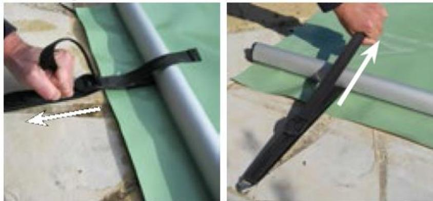
Saisir la sangle fermement et la tirer en direction du crochet, jusqu'à obtenir une tension maximum.
